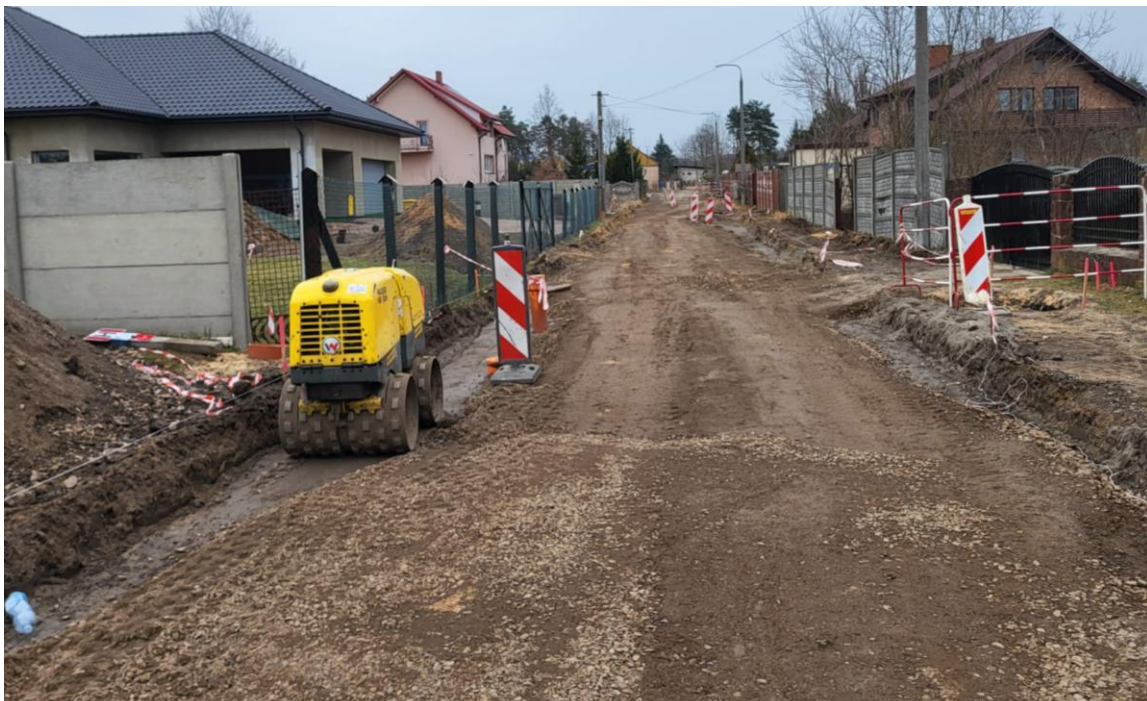
zdjęcie w trakcie realizacji zadania
