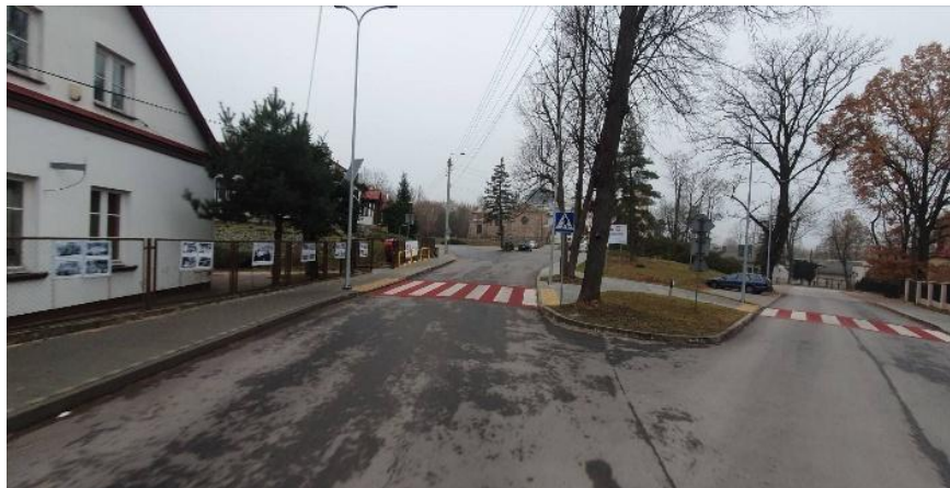
Zdjęcie po zakończeniu robót
