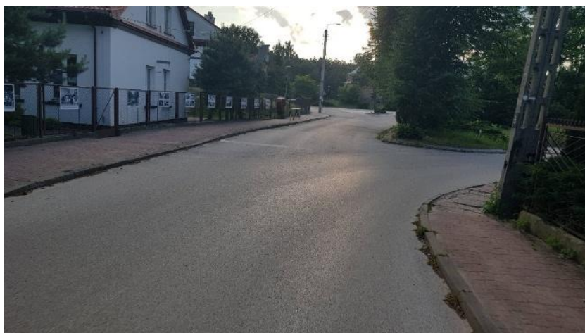
Zdjęcie przed rozpoczęciem realizacji zadania
