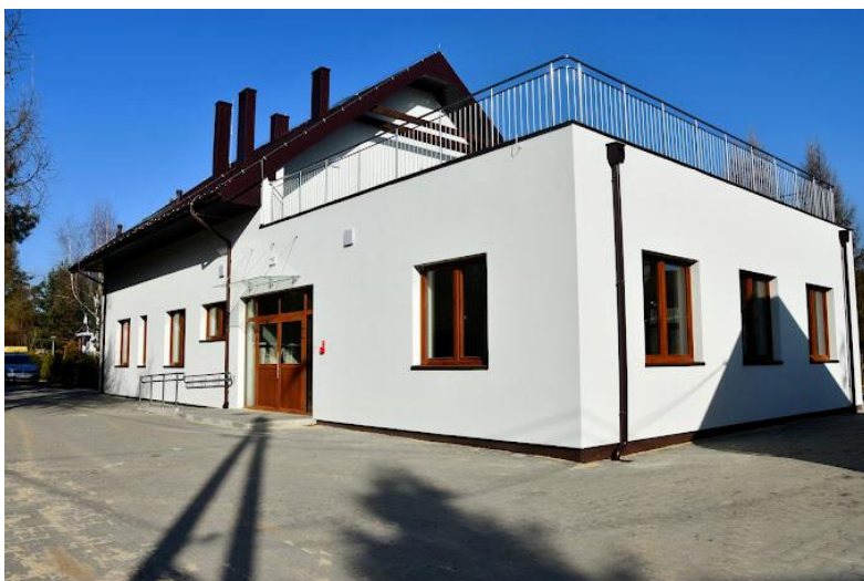
Zdjęcie w trakcie realizacji zadania
